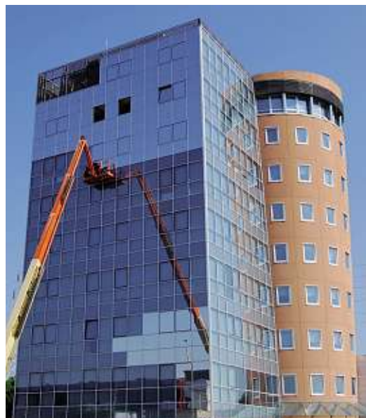
La MG Tower di corso Stati Uniti durante i lavori per l'applicazione dei filtri Abires. Appositi sensori stanno ora rilevando ogni variazione di temperatura, illuminazione e umidità relativa.
