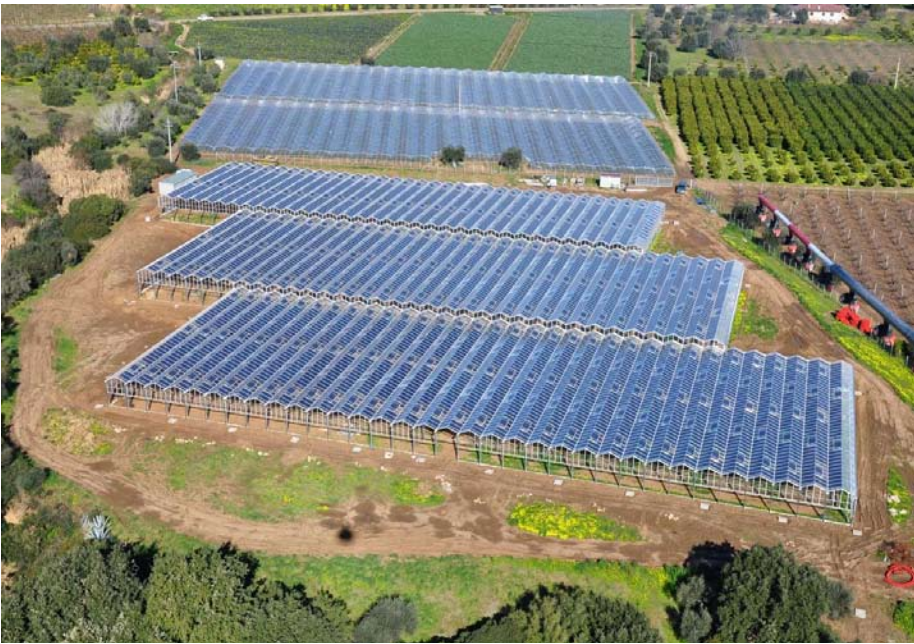
Serra fotovoltaica da un megawatt installata a Potenza da Maniero Elettronica sopra una coltivazione di manghi. Mentre sono stati proibiti gli impianti a terra, questo tipo di soluzione è ancora ammessa purché garantisca una determinata trasparenza.
