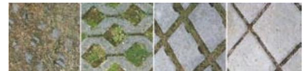
Tipologie di pavimentazione permeabile per parcheggio
